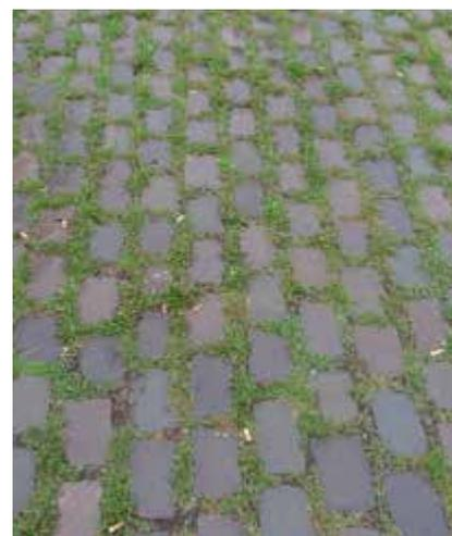
Abb. 100: Pflasterung mit breiten, begrünten Fugen
