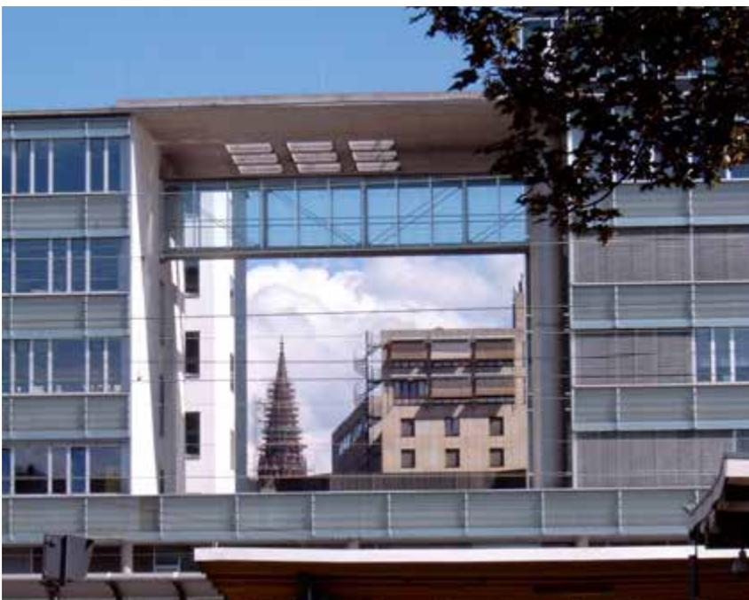
Abb. 74: Windfenster im Hauptbahnhof von Freiburg im Breisgau; der Gebäuderiegel verhindert eigentlich den Luftaustausch, dank der Öffnungen im Gebäude wird der rückwertige Siedlungsbereich zumindest punktuell mit Kaltluft versorgt.
