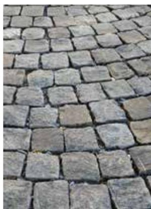
Abb. 103: Pflasterung mit offenen, nicht zementierten Fugen
