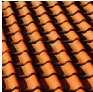
Abb. 139: Albedowert Dachziegel 0,1–0,35
